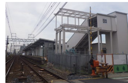
堺市内連続立体交差事業(諏訪ノ森駅部)
