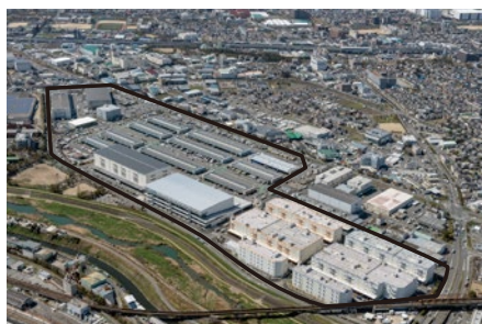
北大阪流通センター (総敷地面積 約272,000㎡)
