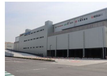
北大阪トラックターミナル1号棟
