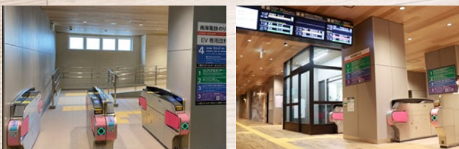
2階にあった改札口を1階南北通路両側(東・西)に移設
