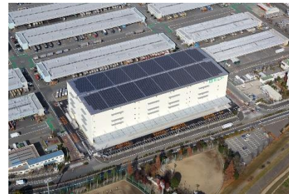
北大阪トラックターミナルの太陽光発電
