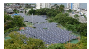
淡輪太陽光発電所
