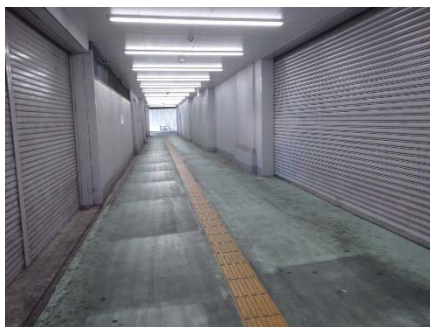
1階南北通路(現状)
