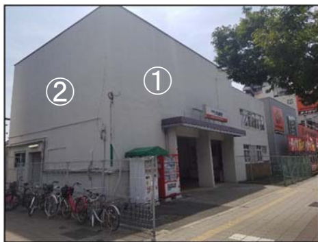
●施工前の汐見橋駅駅舎●
