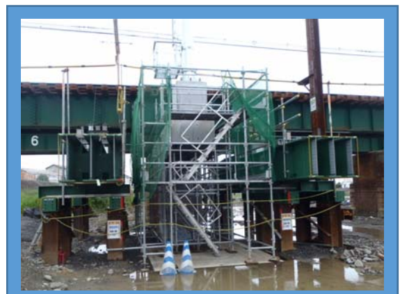
本復旧工事が進む男里川橋梁 (5月8日撮影)
