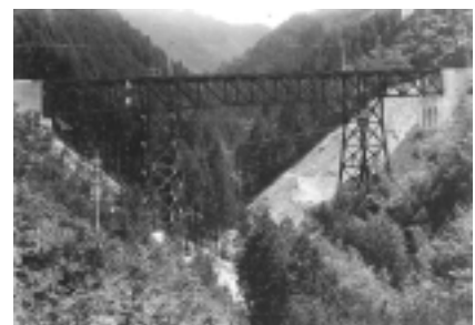
中古沢橋梁(昭和初期)
