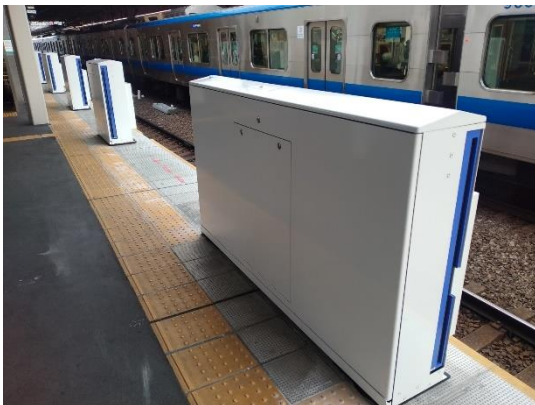
設置工事中の中百舌鳥駅3番線ホームドア
