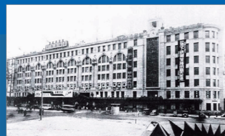
1932年「南海ビルディング」高島屋大阪店全館開業 1932: Opening of Osaka Takashimaya in the Nankai Building
