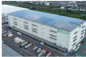
北大阪トラックターミナル2号棟
