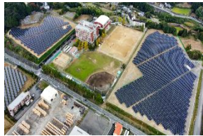
南海小峰台太陽光発電所
