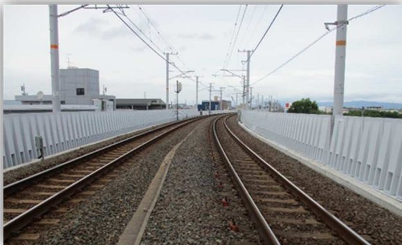
ブロック高欄改修
