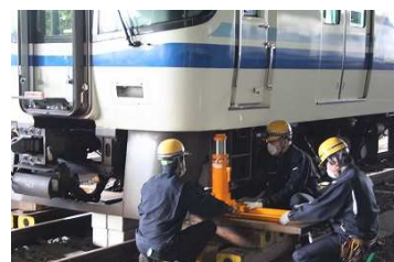
脱線車両の復旧
