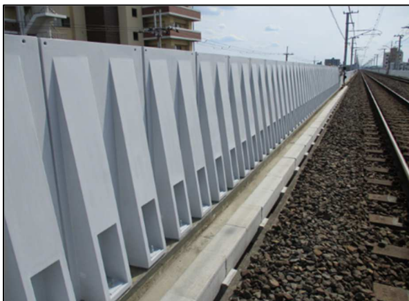
ブロック高欄改修
