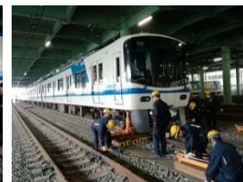
脱線車両の復旧
