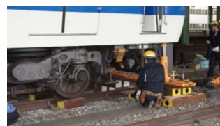
脱線車両の復旧
