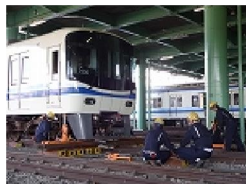
脱線車両の復旧
