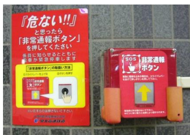
非常通報ボタン
