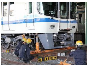
脱線車両の復旧
