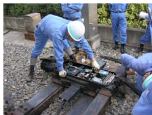
電気転てつ器の整備
