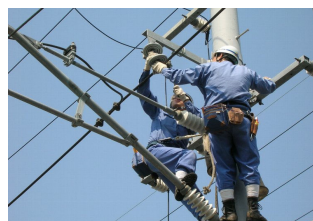
電車線の点検
