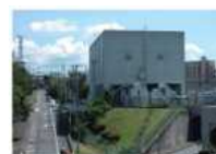
光明池変電所
