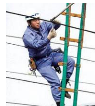
電車線の点検
