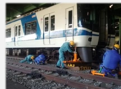
車両脱線復旧作業
