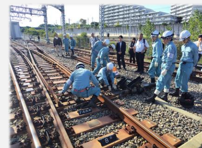
線路設備復旧作業
