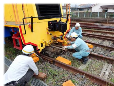
軌道作業車脱線復旧訓練
