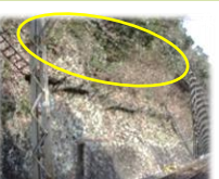
落石警報装置 17箇所
