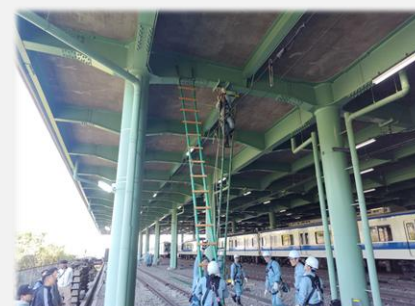
電線路設備復旧作業
