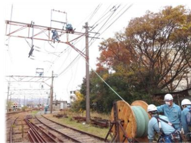
電線路設備復旧訓練
