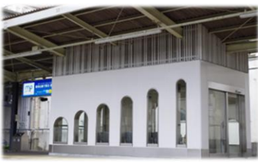
金剛駅下りホーム待合室改修
