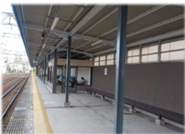
住吉東駅ホーム上屋スレート屋根鋼製化
