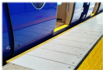
④ くし状ゴム (ホームと車両の隙間対策)
