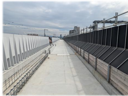
南海本線（堺市内）連続立体交差事業 諏訪ノ森駅～浜寺公園駅間
