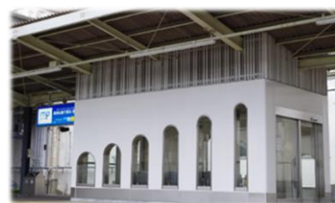
金剛駅下りホーム待合室改修
