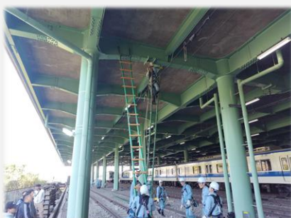
電線路設備復旧作業
