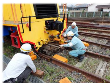
軌道作業車脱線復旧訓練
