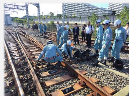
線路設備復旧作業
