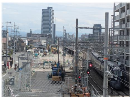
南海本線（堺市内）連続立体交差事業 浜寺公園駅部
