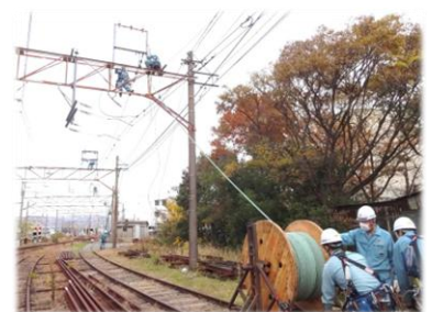
電線路設備復旧訓練
