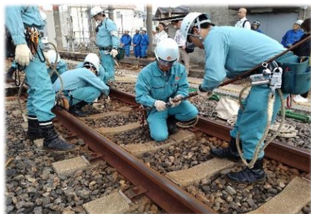
電線路設備復旧作業
