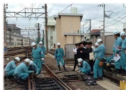
線路設備復旧作業
