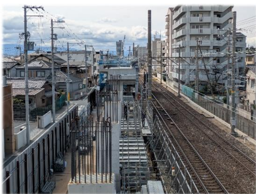
南海本線（堺市）連続立体交差事業 諏訪ノ森駅～浜寺公園駅間
