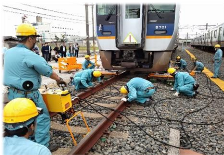
車両脱線復旧作業
