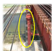
河川水位警報装置 17箇所
