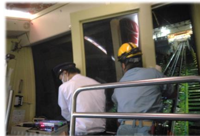
車両前面扉取り外しの様子
