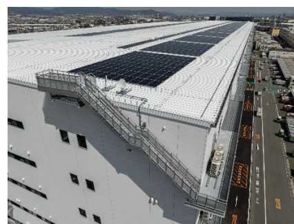
太陽光パネル
