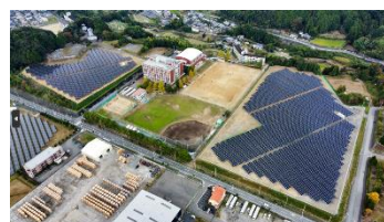
南海小峰台太陽光発電所
