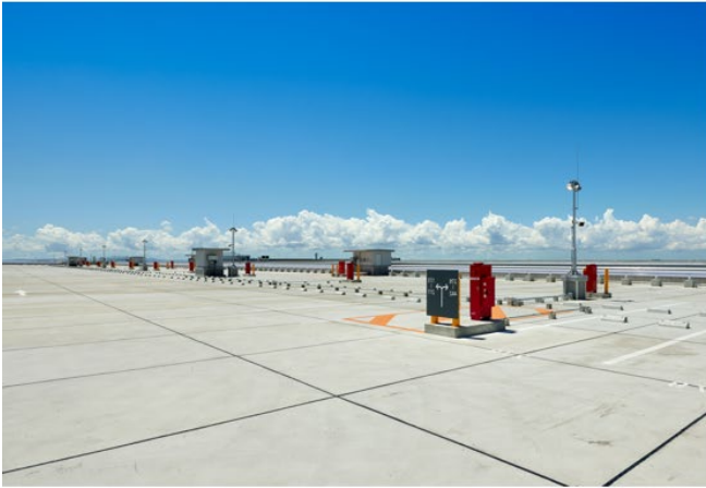
【A 棟屋上駐車場】
