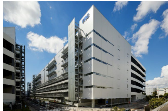
物流ビル A 棟（2023 年 8 月竣工）
