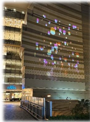
2階南側壁面「ランタンサウスウォール」
