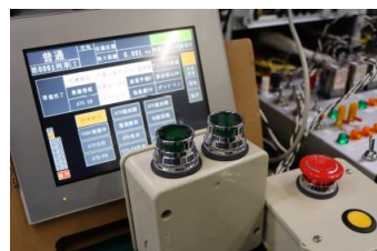
車両設備(乗務員操作部)
