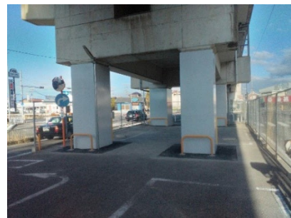
高架橋柱耐震補強
