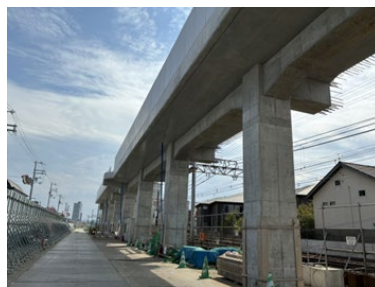
諏訪ノ森駅～浜寺公園駅間 高架橋
