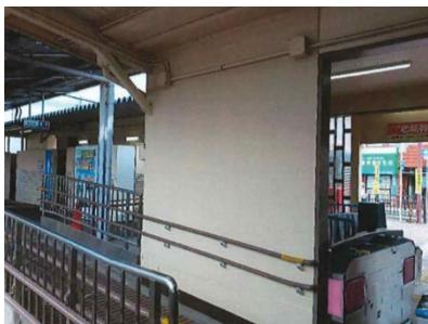
樽井駅舎耐震壁設置
