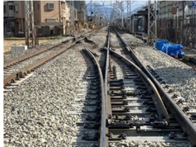
代替設備(渡り線)敷設工事の状況
