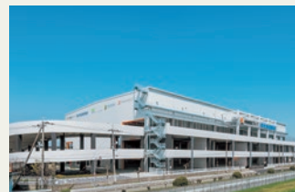
大阪府食品流通センター E棟 （北大阪流通センター）
