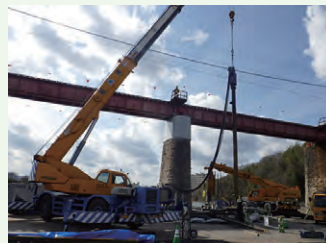
洗掘防止対策(高野線紀ノ川橋梁)
