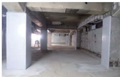
なんば駅構内の高架橋の耐震補強工事
