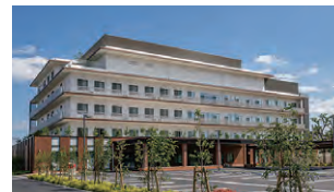
介護老人保健施設の新築工事
