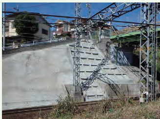
法面崩壊対策(千代田駅~河内長野駅間)
