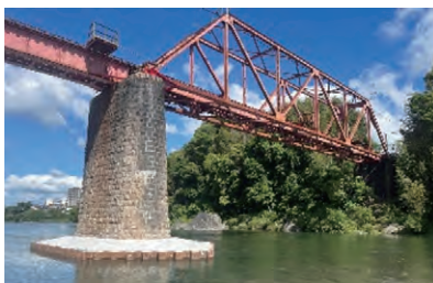
高野線紀ノ川橋梁 橋脚洗掘防止対策工事
