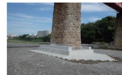
高野線紀ノ川橋梁 P3橋脚洗掘防止対策工事
