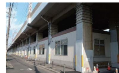
粉浜駅~住吉大社駅間 高架橋柱耐震補強工事
