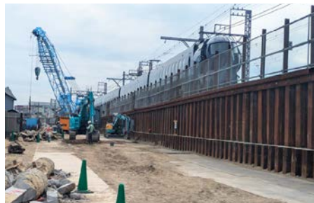
南海本線堺市内連続立体交差事業 (石津川駅～諏訪ノ森駅間)
