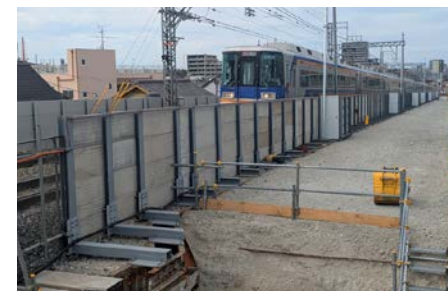
南海本線堺市内連続立体交差事業 (浜寺公園駅～羽衣駅間)
