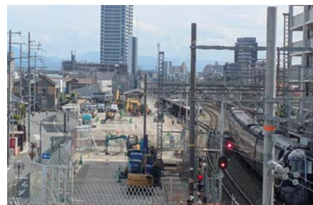
南海本線堺市内連続立体交差事業 （浜寺公園駅間）
