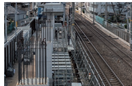
南海本線堺市内連続立体交差事業 (諏訪ノ森駅～浜寺公園駅間)
