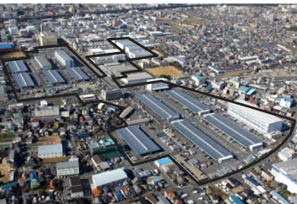
東大阪流通センター (総敷地面積 約213,000㎡)
