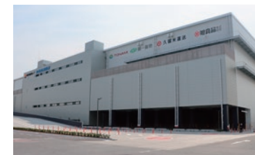
北大阪トラックターミナル1号棟
