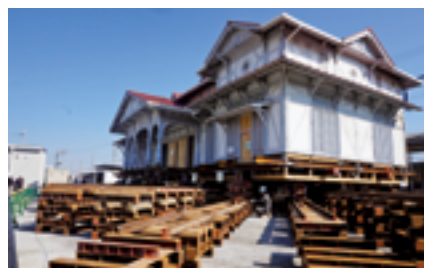
浜寺公園旧駅舎曳家工事
