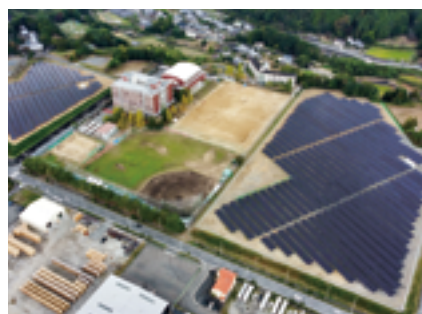
南海小峰台太陽光発電所
