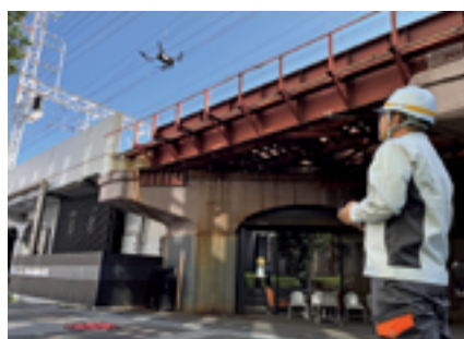
ドローンを活用した点検
