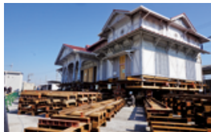
浜寺公園旧駅舎曳家工事
