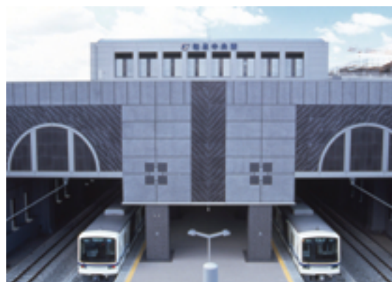
竣工した和泉中央駅（1995年3月）
