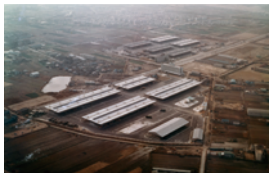
整備される東大阪流通センター
