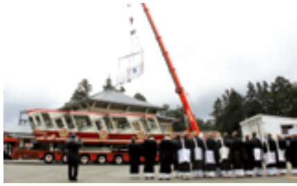
クレーンを使用した新車両の搬入作業
