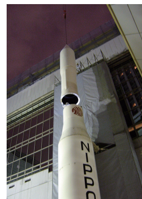
撤去作業の様子
