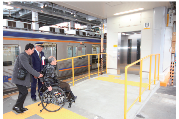
橋本駅ホームのエレベーター
