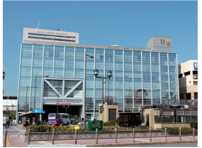
南海堺駅ビル
