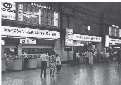
昭和37年ごろの難波駅コンコース。2階には、ドーム型の屋根を持つプラットフォームが健在だった。
