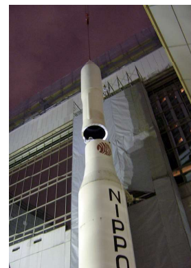
撤去作業の様子
