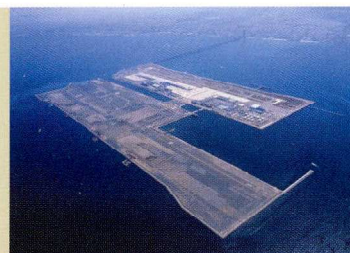
関西国際空港 (平成17年5月撮影)
