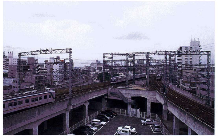
大阪市内連続立体交差 (平成7年11月竣工)
