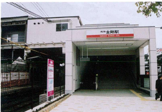
各駅舎でエスカレーター設置など利便性を向上
