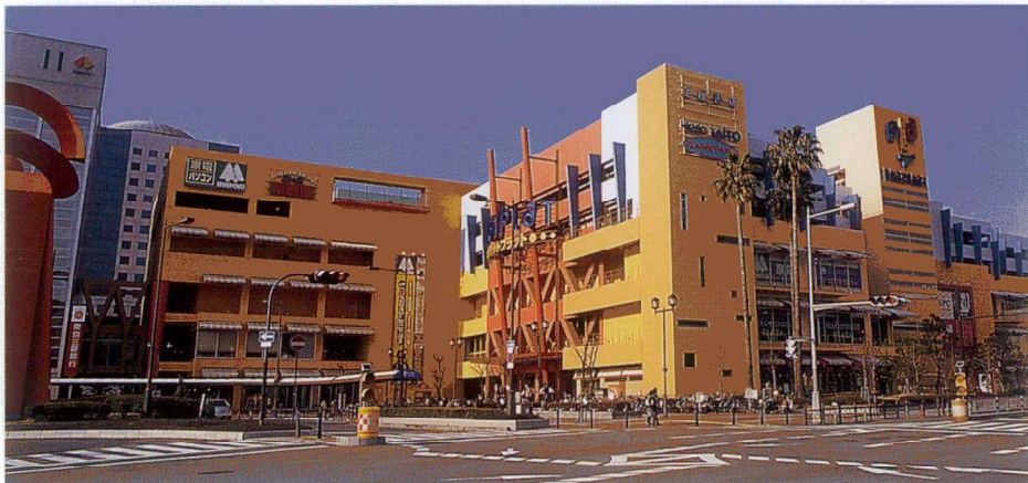
プラットプラット (平成12年7月オープン)
