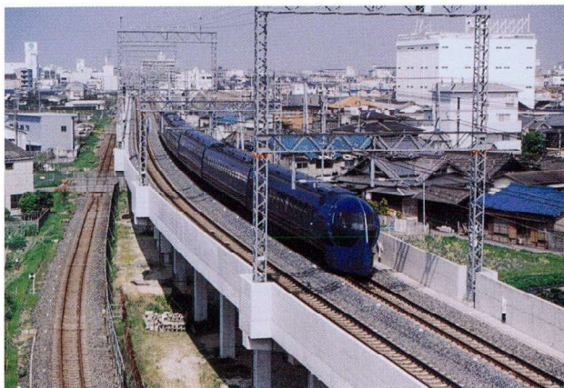
南海本線貝塚中央線単独立体交差事業(貝塚～二色浜間)上り線を切り替え完了(平成10年11月)
