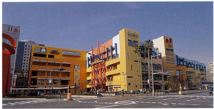
プラットプラット外観
