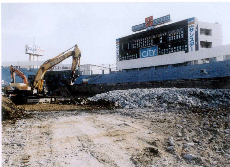
平成10年11月に開始された大阪球場の解体工事
