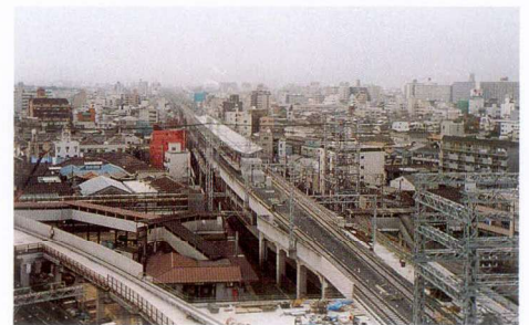
大阪市内連立工事・岸里玉出駅付近(平成5年4月)
