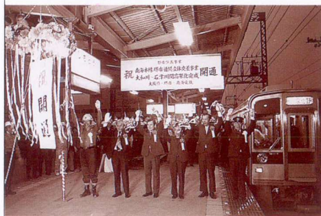
堺市内大和川～石津川間高架が完成し開通(昭和60年5月)
