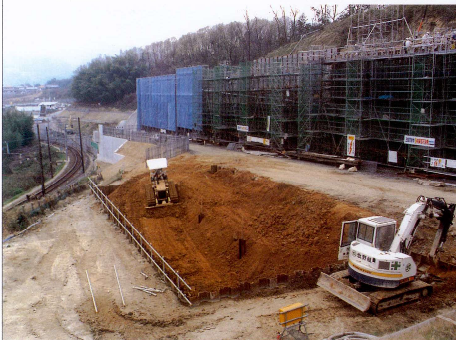
擁壁工事中の小原田車庫(平成4年4月)
