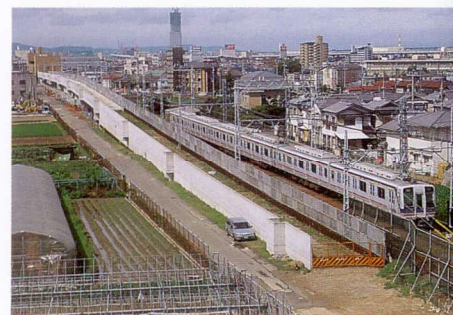
単独立体交差化工事の下り線高架橋(貝塚駅付近・平成7年6月)
