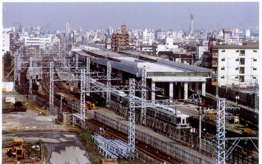
大阪市内連立工事・天下茶屋駅付近(平成元年9月)
