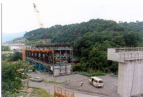
菖蒲谷川橋梁の架橋工事(平成5年8月)
