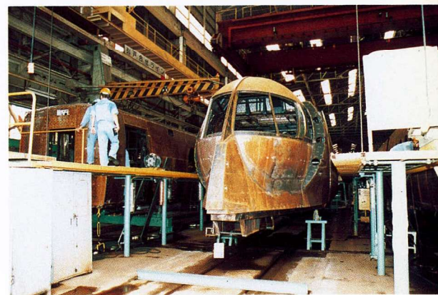
建造中のラビート（平成5年9月）
